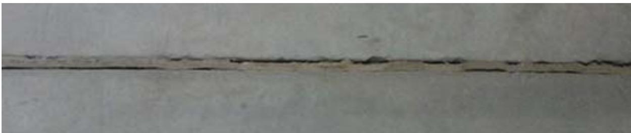
Чтобы этого не происходило, важно, выдержать необходимое время. Важно сначала обеспылить шов промышленным пылесосом, затем загрунтовать шов, а после нанесения грунта необходима выдержка 6-8 часов, и только потом можно нанести герметик. В противном случае герметик может «прилипнуть» к тому, что ближе, - не к бетону, а к пыли в швах.
